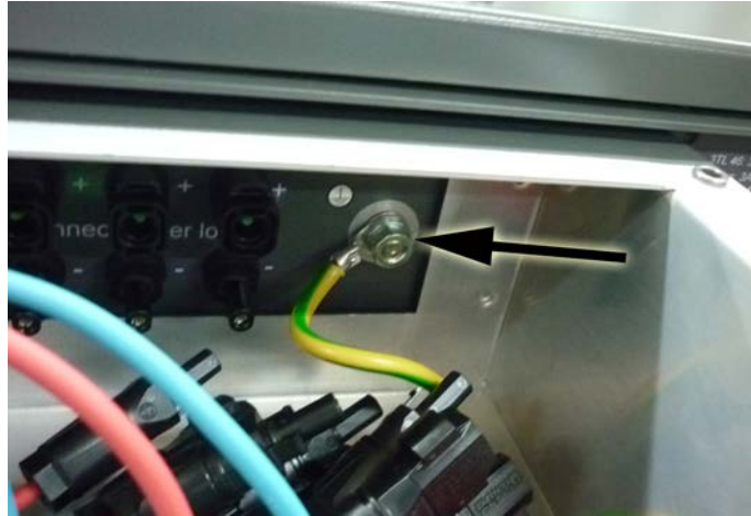
Bild 30: Interne PE-Verbindung der ConnectionBox herstellen
