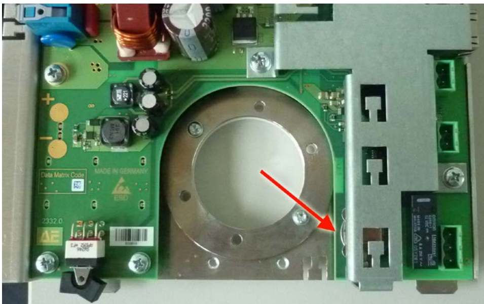
Bild 27: Lage der Batterie (Pfeil)
