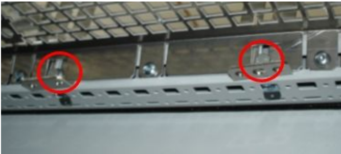
Bild Nr.7 Bügelschrauben rechts, Dach aufgestellt
