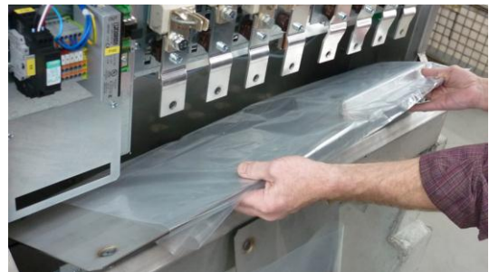
Bild 19: Entnehmen der Bleche für Kabeleinführung
