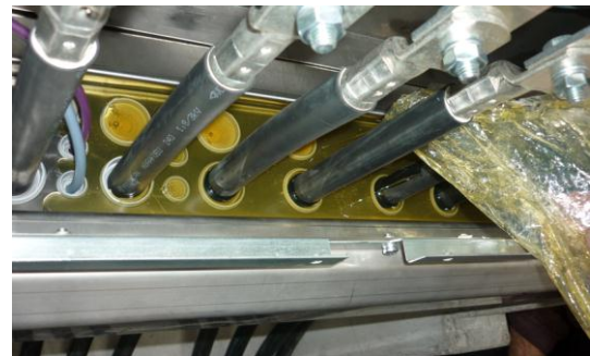
Bild 32: Kabelharz einbringen
