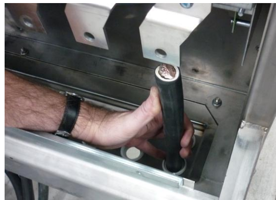
Bild 26: Kabel durchziehen
