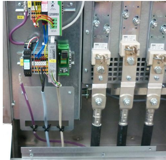
Bild 28: Verkabelung Kommunikation
