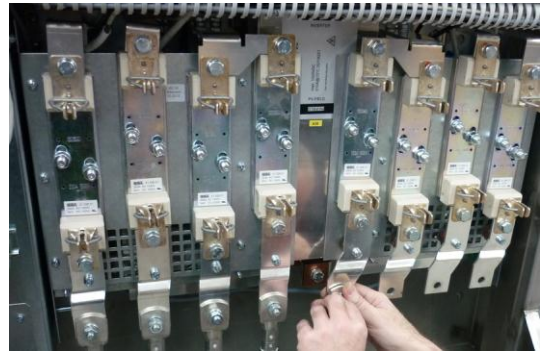
Bild 27: Kabelschuhe befestigen
